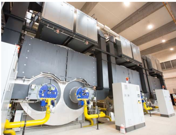
Abbildung 10 Doppelkesselanlage 32 MW (am Beispiel Fernheizwerk Klagenfurt 2)
